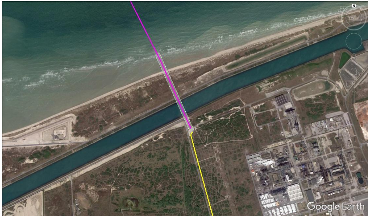
Figure 12 Zone de forage dirigé horizontal pour le franchissement du trait de côte à Dunkerque
